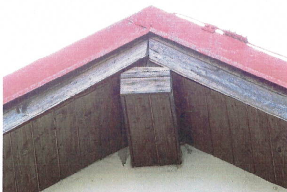
č. 7 – 11 Detaily spojení střešní konstrukce s obvodovým zdívem
