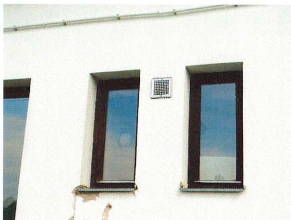
č. 23 – 24 Detaily VO v obvodovém plášti, jižní a severní průčelí
